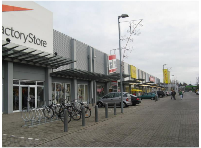
Ochtum Park Outlet Center, Stuhr-Brinkum (D) MiRo Grundstücksverwaltung GmbH
