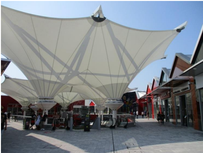
Scalo Milano Outlet & more, Locate di Triulzi (I) Locate District Spa
